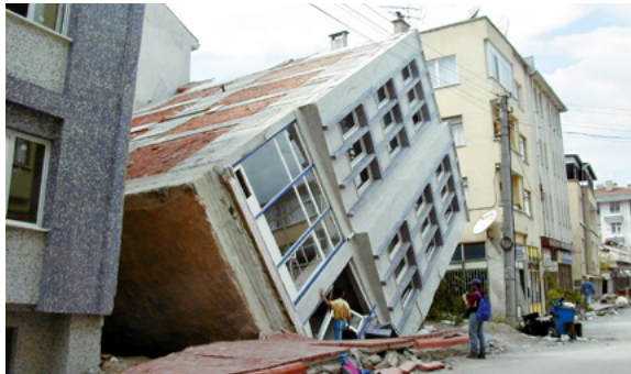
Séisme d'Izmit (Turquie), 1999 © Pierre Mouroux – BRGM pour la mission d'évaluation des dommages – AFPS
